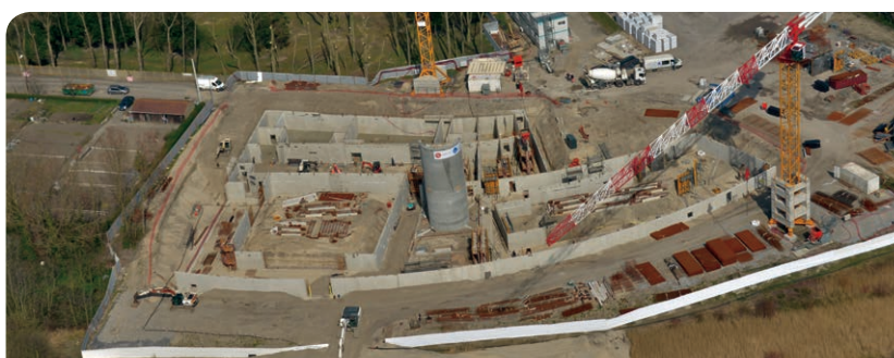
La vue aérienne permet de bien observer l'avancée des travaux de la piscine intercommunale.
